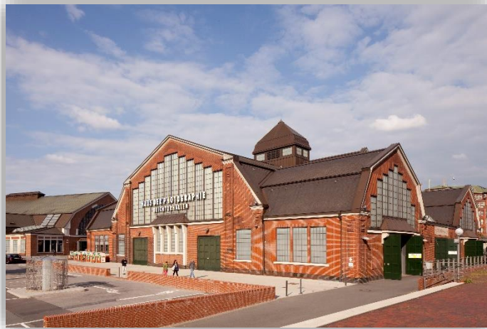
Außenansicht Haus der Photographie
